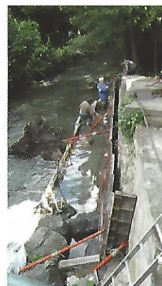
Réfection de berges
